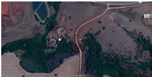
Figura 2 – Localização da ponte sobre o Ribeirão Abóbora no município de Rio Verde
