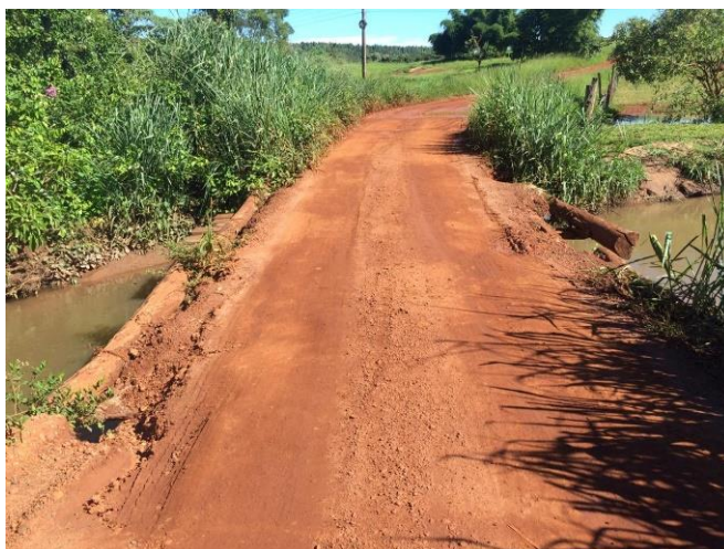
Figura 3 – Ponte vicinal sobre o Ribeirão Abóbora no município de Rio Verde
