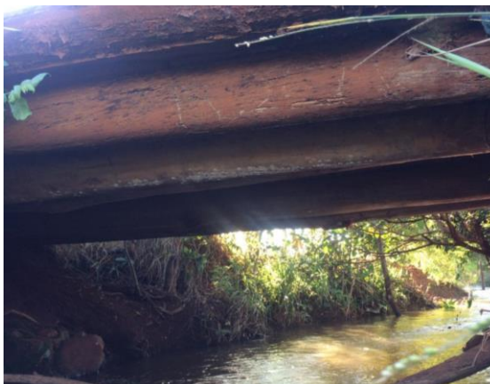
Figura 19 – Posicionamento das longarinas da ponte sobre o Córrego Douradinho Fonte: Próprio autor (2019)
